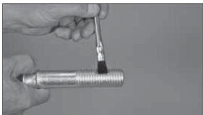
**5. SCHRAUBENGEWINDE SCHMIEREN:** Tragen Sie eine dünne Schicht Victaulic Schmiermittel oder Silikonschmiermittel auf die Schraubengewinde auf. **ANMERKUNG:** Wenn Edelstahlschrauben und -muttern bestellt wurden, tragen Sie Gleitmittel auf die Schraubengewinde auf.
