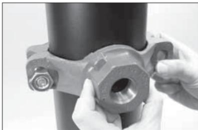
**3a.** Sicherstellen, dass der Positioniererring richtig in das Loch einrastet. Den festen Sitz durch Rütteln an der oberen Gehäusehälfte (Auslass) im Loch überprüfen.
