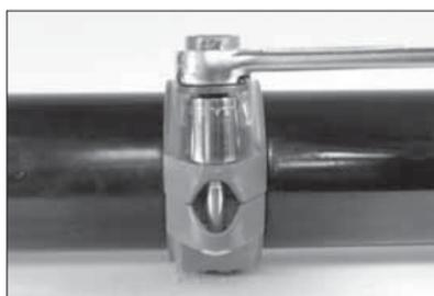
**8. MUTTERN FESTZIEHEN:** Ziehen Sie alle Muttern gleichmäßig über Kreuz fest, bis an den Passflächen Metall auf Metall trifft. Stellen Sie sicher, dass die Federn der Gehäusehälften vollständig in die Nuten eingreifen. **ANMERKUNG:** Es ist wichtig, alle Muttern gleichmäßig festzuziehen, um ein Einklemmen der Dichtung zu verhindern.
