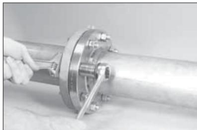
**8. DIE ÜBRIGEN SCHRAUBEN/ MUTTERN MONTIEREN:** Stecken Sie eine Standard Vollschaftschraube durch jedes der übrigen Löcher im Vic-Flange Adapter und im Gegenflansch. Drehen Sie eine Mutter von Hand auf jede Schraube, bis diese handfest angezogen ist.
