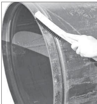
1b. Reinigen Sie die Außenseite des Rohrs von der Nut bis zum Rohrende, um Öl, Fett, losen Lack und Schmutz zu entfernen.
