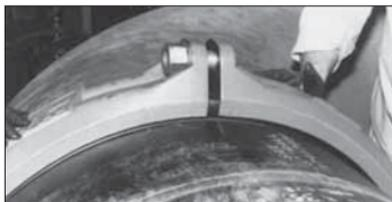
**3. ERSTE SEGMENTBAUGRUPPE INSTALLIEREN:** Installieren Sie eine der vormontierten Hälften über die Dichtung. Stellen Sie sicher, dass die Federn der Gehäusehälfte vollständig in die Nuten an beiden Rohrenden einrasten.
