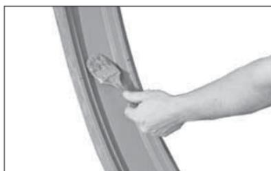
**2. DICHTUNG PRÜFEN UND SCHMIEREN:** Überprüfen Sie die Dichtung und stellen Sie sicher, dass sie für die beabsichtigte Anwendung geeignet ist. Die Dichtungsklasse wird durch den Farbcode angezeigt. Tragen Sie eine dünne Schicht Victaulic Schmiermittel oder Silikonenschmiermittel auf die Dichtungslippen und das Äußere der Dichtung sowie auf die Innenseite der Kupplungsgehäusehälfte auf.
