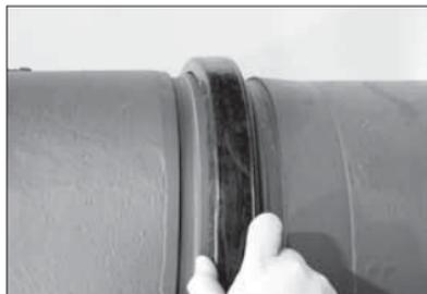
**4a. Wenn die Dichtung bei größeren (nicht-AGS) Kupplungen in Schritt 3a umgestülpt wurde:** Rollen Sie die Dichtung in Position und zentrieren Sie sie zwischen der Nut im jeweiligen Rohr. Stellen Sie sicher, dass kein Teil der Dichtung in die Nut an den Rohrenden reicht.
