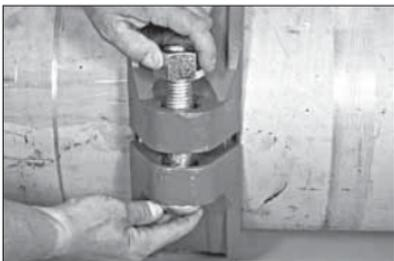
**7. SCHRAUBEN/MUTTERN MONTIEREN:** Montieren Sie die Schrauben und drehen Sie eine Mutter von Hand auf jede Schraube. **ANMERKUNG:** Stellen Sie sicher, dass der ovale Schraubenhals jeder Schraube richtig im jeweiligen Schraubenloch sitzt.
