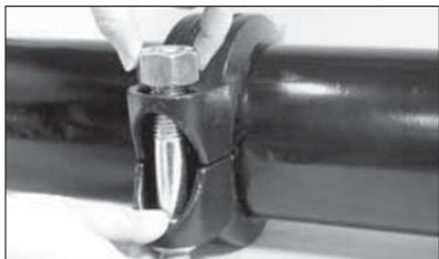
**6. SCHRAUBEN/MUTTERN MONTIEREN:** Montieren Sie die Schrauben und drehen Sie eine Mutter von Hand auf jede Schraube. **ANMERKUNG:** Stellen Sie sicher, dass der ovale Schraubenhals jeder Schraube richtig im jeweiligen Schraubenloch sitzt.
