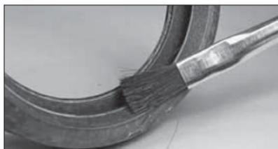
3. **DICHTUNG SCHMIEREN:** Tragen Sie auf die Dichtungslippen und das Äußere der Dichtung eine dünne Schicht Victaulic Schmiermittel oder SilikonSchmiermittel auf. Es ist normal, dass die Dichtfläche trüb weiß erscheint, nachdem die Dichtung im Einsatz war. **ANMERKUNG: GEHÄUSE UND DICHTUNGEN FÜR KUPPLUNGEN DES TYP 107H UND GEHÄUSE UND DICHTUNGEN FÜR KUPPLUNGEN DES TYP 107 KÖNNEN NICHT UNTEREINANDER AUSGETAUSCHT WERDEN.**
