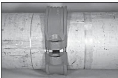
**6. GEHÄUSEHÄLFTEN MONTIEREN:** Montieren Sie die Gehäusehälften über die Dichtung. Stellen Sie sicher, dass die Federn des Gehäuses an beiden Rohrenden ganz in die Nuten oder den AGS Vic-Ring einrasten. Stützen Sie die Segmente ab, wenn Sie die Montage der Schrauben und Muttern vorbereiten.
