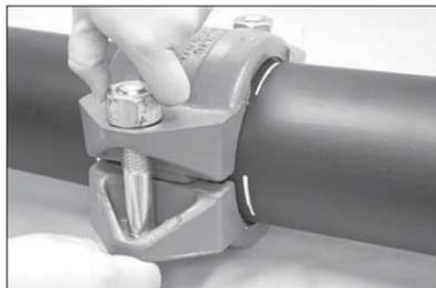
**7. SCHRAUBEN/MUTTERN INSTALLIEREN:** Stecken Sie die Schrauben in die Bohrungen und drehen Sie je eine Mutter von Hand auf jede Schraube. **ANMERKUNG:** Stellen Sie sicher, dass die ovalen Schraubenhälse richtig in den Schraubenlöchern sitzen.
