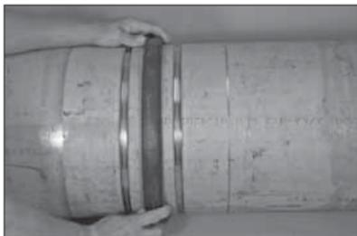
**4. ROHRENDEN VERBINDEN:** Fluchten Sie die beiden Rohrenden und führen Sie sie zusammen. Schieben Sie die Dichtung in Position und zentrieren Sie sie zwischen der Nut im jeweiligen Rohrende oder dem AGS Vic-Ring.
