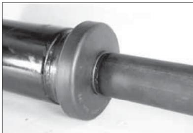
**4. ROHRENDEN VERBINDEN:** Fluchten Sie die Mittellinien der Rohre aus und führen Sie das kleinere Rohrende in die Dichtung ein. Stellen Sie sicher, dass kein Teil der Dichtung in die Rohrrut hineinragt.
