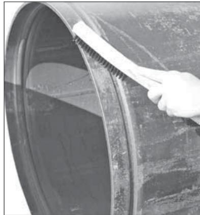
1b. Reinigen Sie die Außenseite des Rohrs von der Nut bis zum Rohrende, um Öl, Fett, losen Lack und Schmutz zu entfernen.
