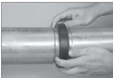
**4. ROHRENDEN VERBINDEN:** Fluchten Sie die beiden Rohrende aus und führen Sie sie zusammen. Schieben Sie die Dichtung in Position und zentrieren Sie sie zwischen der Nut im jeweiligen Rohr. Stellen Sie sicher, dass kein Teil der Dichtung in die Nut an den Rohrenden reicht.
