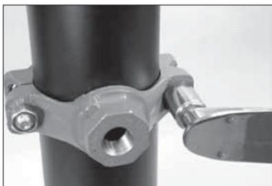
**5. MUTTERN FESTZIEHEN:** Zuerst sicherstellen, dass der Positioniererring noch richtig im Auslassloch sitzt. Die Muttern gleichmäßig und wechselseitig anziehen, bis die obere Gehäusehälfte (Auslass) das Rohr ganz berührt.
