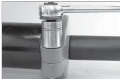
**7. MUTTERN FESTZIEHEN:** Ziehen Sie alle Muttern gleichmäßig über Kreuz fest, bis an den Passflächen Metall auf Metall trifft. Stellen Sie sicher, dass die Federn der Gehäusehälften vollständig in die Nuten eingreifen.
