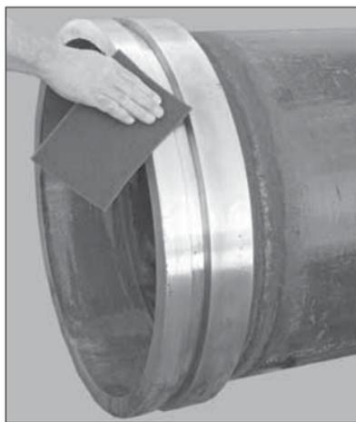
**1b.** Reinigen Sie die äußere Oberfläche der Vic-Ringe, um Schmutz und andere Fremdkörper zu entfernen.
