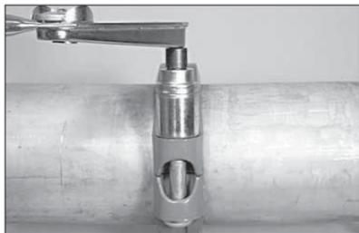
**4. MUTTERN FESTZIEHEN:** Ziehen Sie alle Muttern gleichmäßig über Kreuz fest. Stellen Sie sicher, dass die Federn der Gehäusehälften an beiden Rohrenden vollständig in die Nuten eingreifen. Bringen Sie auf jede Mutter das erforderliche Drehmoment auf. Verwenden Sie dazu einen Drehmomentschlüssel. Beziehen Sie sich für die Drehmomentanforderungen auf die folgende Tabelle. **ANMERKUNG:** Es ist wichtig, alle Muttern gleichmäßig festzuziehen, um ein Einklemmen der Dichtung zu verhindern.
