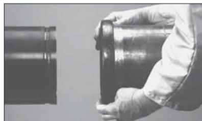
**3. DICHTUNG EINBAUEN:** Schieben Sie die größere Öffnung der Dichtung (mit NPS gekennzeichnet) über das größere Rohrende (NPS-Seite). Stellen Sie sicher, dass die Dichtung nicht über das Rohrende hinausragt.
