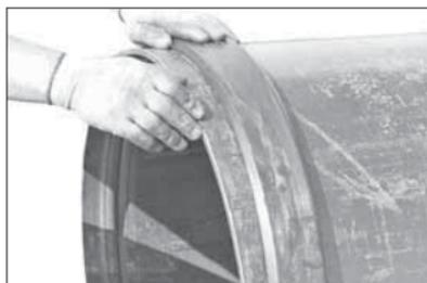
**3. DICHTUNG POSITIONIEREN:** Positionieren Sie die Dichtung auf dem Rohrende oder dem AGS Vic-Ring. Stellen Sie sicher, dass die Dichtung nicht über das Rohrende oder den AGS Vic-Ring hinausragt.
