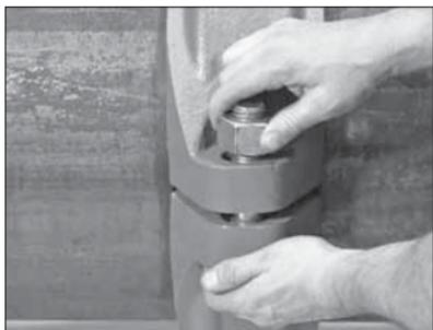
**6. GEHÄUSEHÄLFTEN MONTIEREN:** Montieren Sie die Gehäusehälften über die Dichtung. Stellen Sie sicher, dass die Federn des Gehäuses an beiden Rohrenden ganz in die Nuten oder den AGS Vic-Ring einrasten. Stützen Sie die Segmente ab, wenn Sie die Montage der Schrauben und Muttern vorbereiten.
