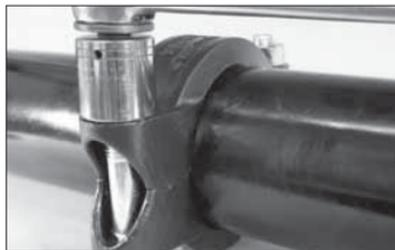
**7. MUTTERN FESTZIEHEN:** Ziehen Sie alle Muttern gleichmäßig über Kreuz fest, bis an den Passflächen Metall auf Metall trifft. Stellen Sie sicher, dass die Federn der Gehäusehälften vollständig in die Nuten eingreifen.
