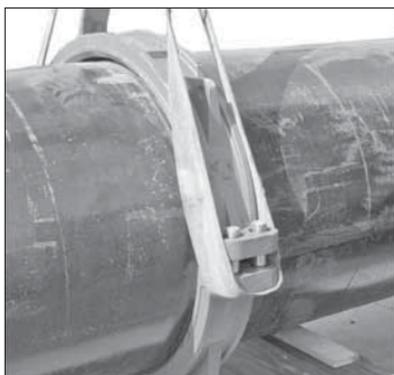
**6. GEHÄUSE INSTALLIEREN:** Installieren Sie die Gehäuse mittels eines dem oben in den Fotos abgebildeten ähnlichen Verlaschungsverfahrens über der Dichtung, wobei die Schrauben in die Schraubenlöcher gesteckt werden. Stellen Sie sicher, dass die Federn des Gehäuses an beiden Rohrenden oder am AGS Vic-Ring ganz in die Nuten einrasten.
