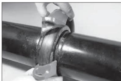
7. **GEHÄUSEHÄLFTEN MONTIEREN:** Montieren Sie die Gehäusehälften über der Dichtung. Vergewissern Sie sich, dass die Federn der Gehäusehälften richtig in die Nuten an beiden Rohren/Anschlusssteilen einrasten.
