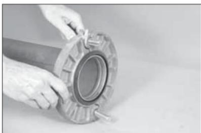
**5b.** Stecken Sie, wenn die Schraubenlöcher fluchten, eine Standard Vollschaftschraube durch das andere Montageloch des Vic-Flange Adapters.
