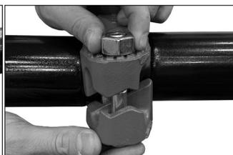
5. **BRINGEN SIE DIE GEHÄUSEHÄLFTEN AN:** Bringen Sie die Gehäusehälften über der Dichtung an. Vergewissern Sie sich, dass die Federn der Gehäusehälften vollständig in die Nuten beider Gegenstücke eingreifen.
